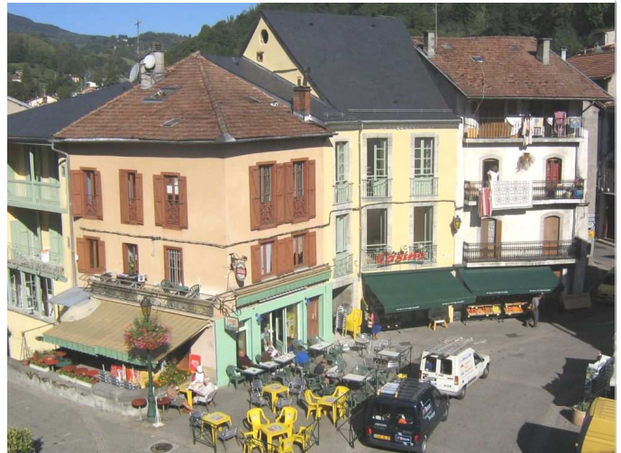
Les 2 immeubles réhabilités de part et d'autre du café « le Central »
